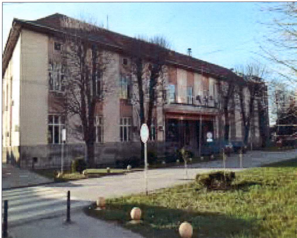
Слика 2. Мерно место бр.1. Ковин - зграда општине
